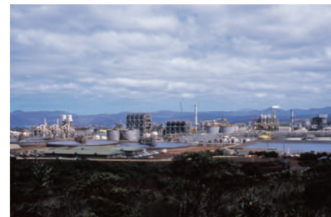
Usine de nickel de Goro
