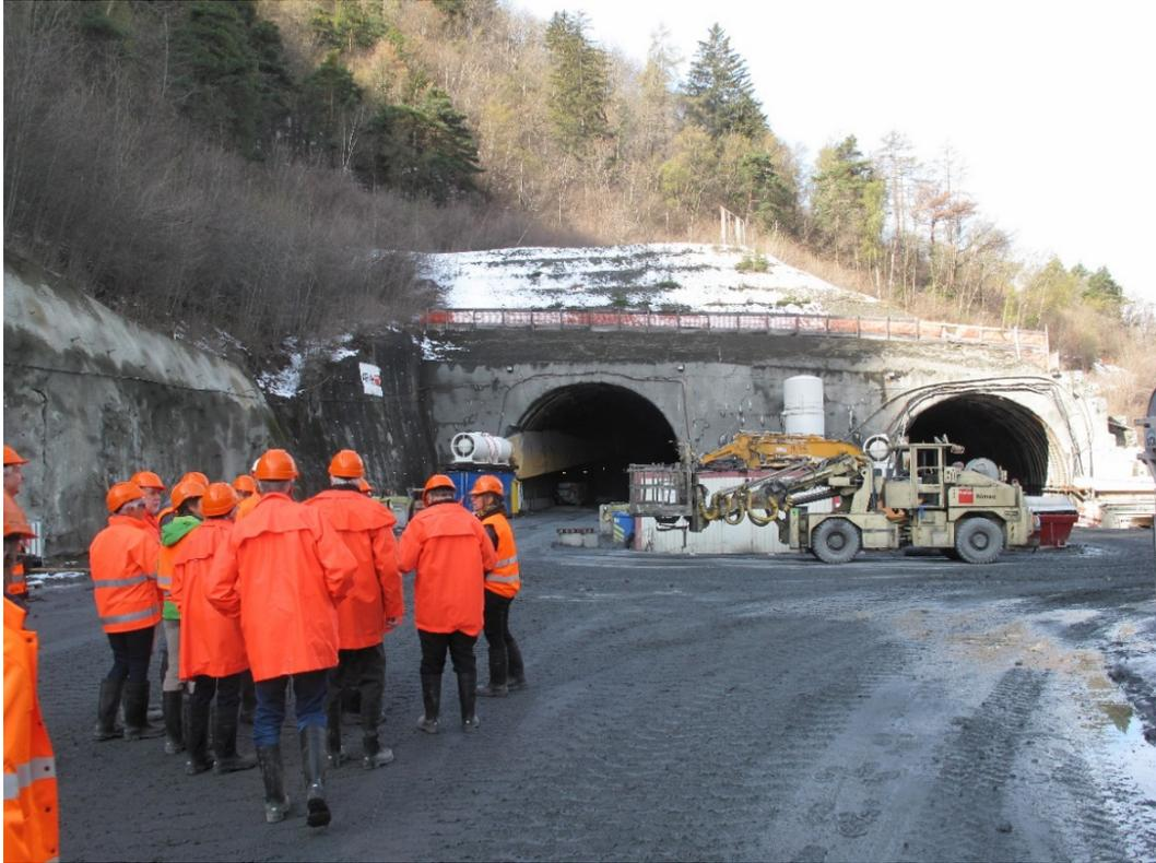
Les portails Est du tunnel Riedberg en cours de creusement avec l'une des excavatrices utilisées.
