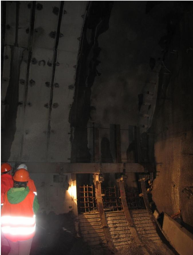
A droite, le front d'attaque de la galerie aval du tunnel Riedberg. On distingue les diverses étapes indispensables avant d'attaquer à la pelleuse la prochaine section de 1,70 m.
