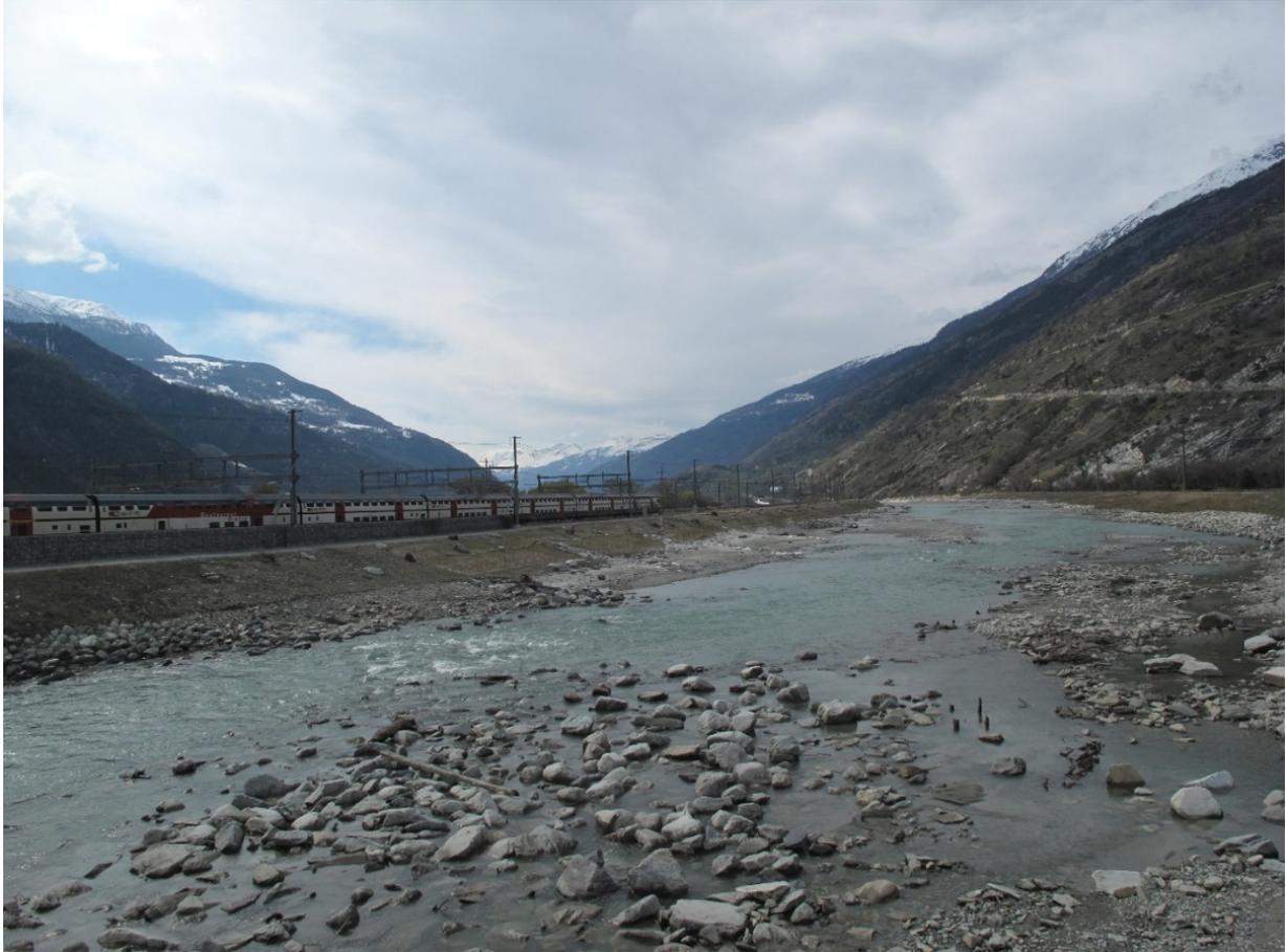
Prise en direction de Sierre, la photo montre une section réaménagée avec des amas de gros blocs formant des épis obligeant le fleuve – actuellement en période d'étiage - à creuser son lit mineur !). A l'arrière-plan, un train à deux étages de la ligne Brigue – Berne empruntant le tunnel de base du Lötschberg.
